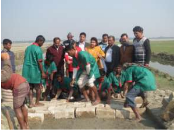
চিত্র-১: কিশোরগঞ্জ হাওর এলাকায় ডুবন্ত রাস্তা নির্মাণ কার্যক্রম পরিদর্শন।
