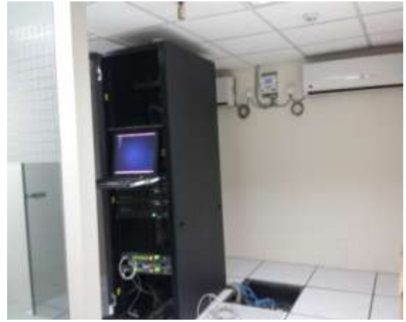
চিত্রঃ WMIP এর আওতায় প্রসেসিং এন্ড ফ্লাড ফোরকাস্টিং সার্কেলে স্থাপিত Server সহ Data Centre কক্ষ
